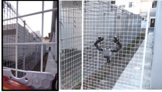
フェンス登攀・高所点検
