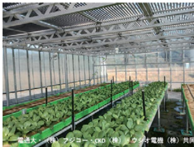
図8-4 ソーラーシェアリング(農電併産、円筒型)
