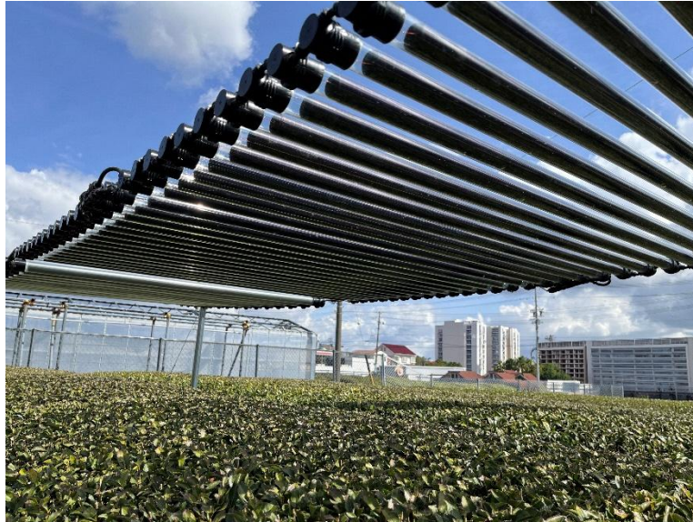
図 1. 吊り橋型円筒形太陽電池と茶葉
