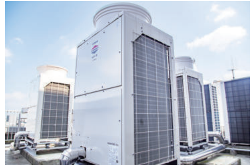
写真1 更新された新しい空調室外観（東6号館）
