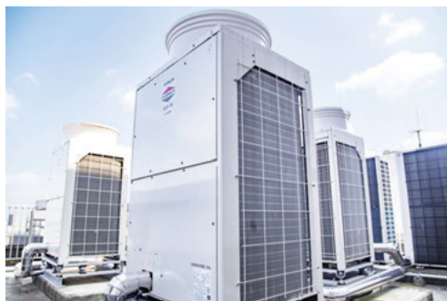
写真1 更新された新しい空調室外観（東6号館）
