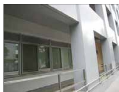
西1号館の耐震フレーム、建具は複層ガラス、網戸付きに改修
