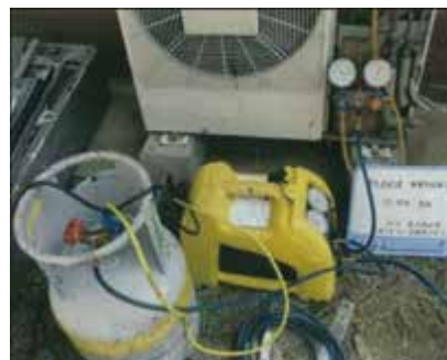
エアコンからのフロンガス回収
