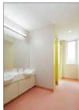
C棟洗面所 節水効果の高い自動水栓
