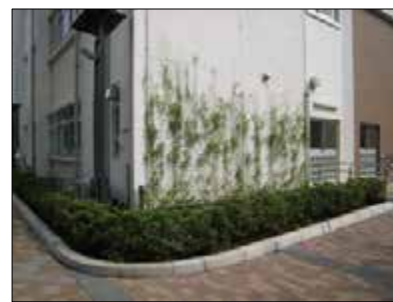
C棟の壁面緑化
