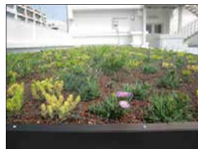
西3号館の屋上緑化
