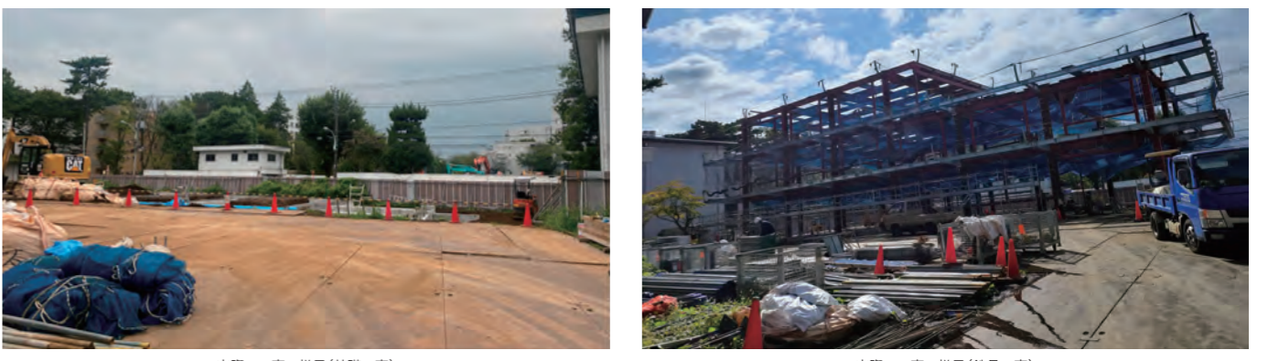
実際の工事の様子(基礎工事)
